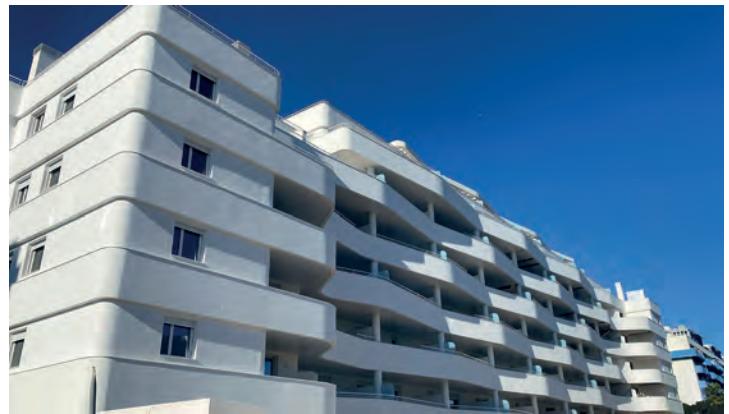
Horus II Torre del Mar, Málaga
