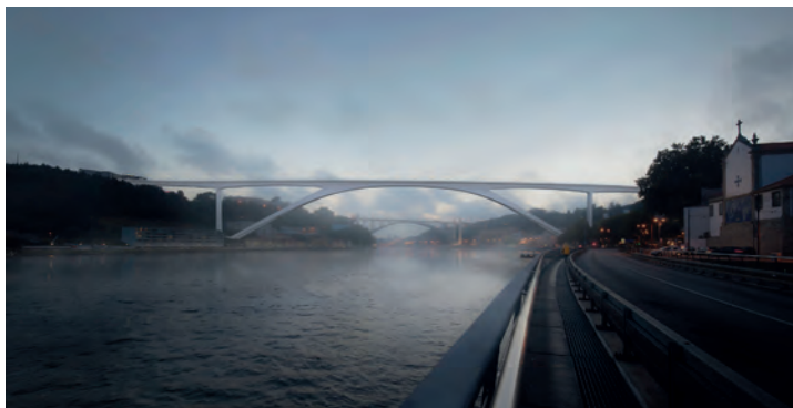
Ponte Ferreira, Oporto
