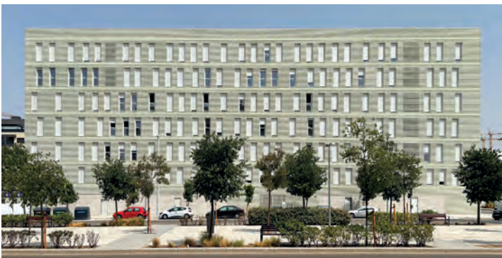
84 viviendas en El Cañaverál, Madrid
