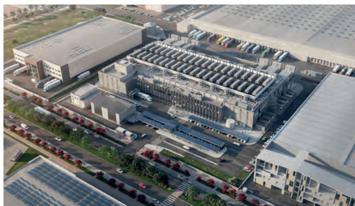
Nuevo Data Center en Madrid
