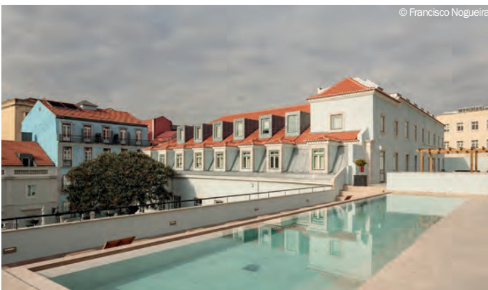
Rehabilitación de Palacio de la Anunciada
