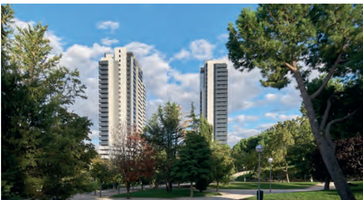
Torres Marqués de Viana: 539 viviendas de protección pública en Madrid
