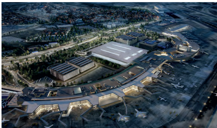
Ampliación Barajas T123 (Madrid)
