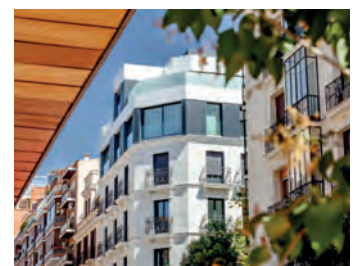
Rehabilitación residencial LR15, Madrid
